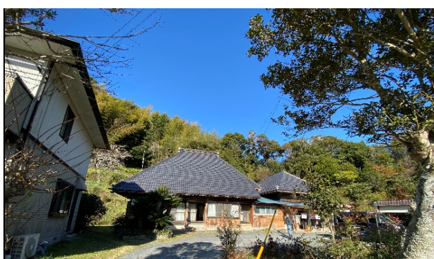
写真番号 5 調査場所 建物外観
