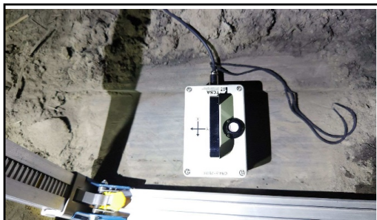
建物地震計設置写真
