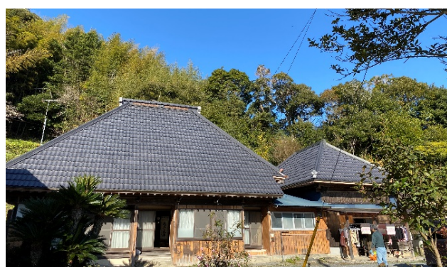
写真番号 6 調査場所 建物外観
