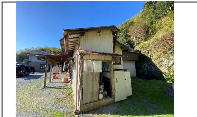
写真番号 1 調査場所 東建物外観
