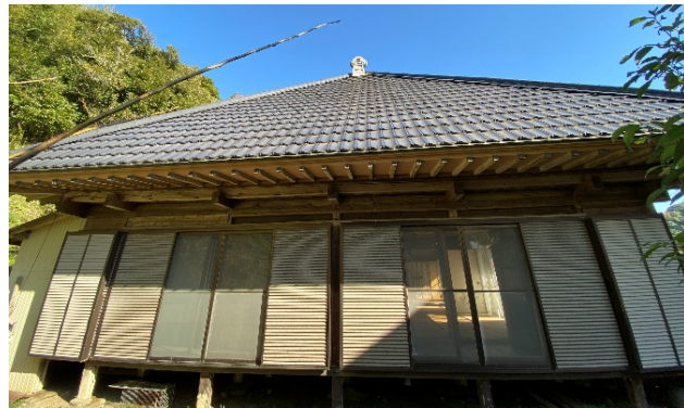
写真番号 2 調査場所 西建物外観
