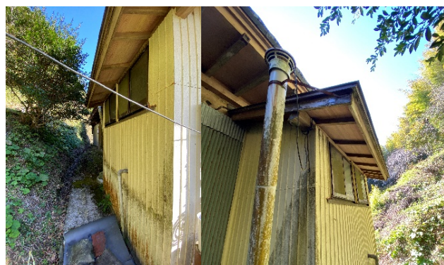
写真番号 4 調査場所 北建物外観
