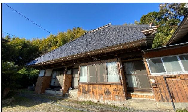
写真番号 3 調査場所 南建物外観
